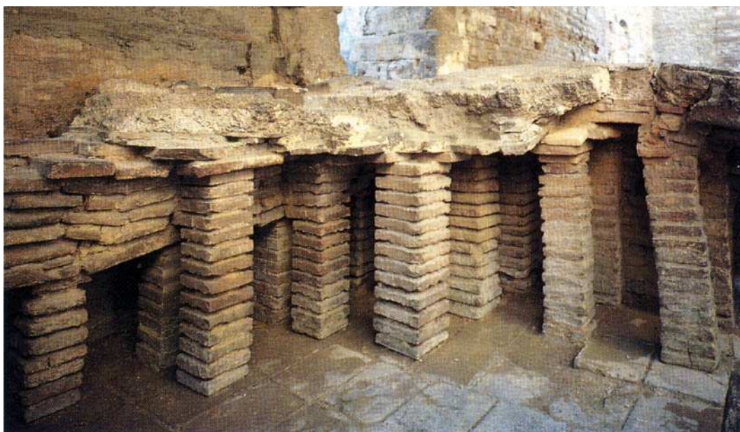
Vestiges de l'hypocauste supporté par les pillettes
