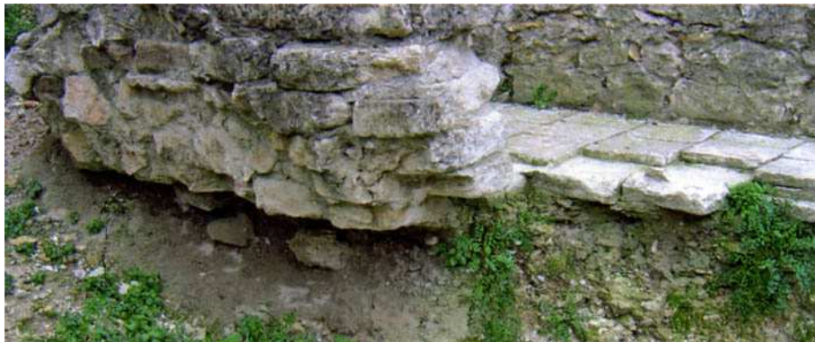
Figure 11 : Aménagement moderne appuyé sur le parement est du mur us 2004 (Cl. F. Raynaud)
