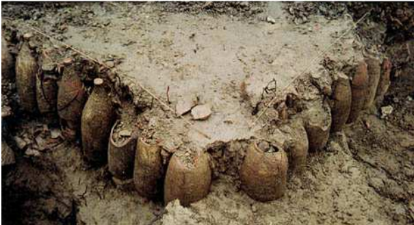
Doc 2 : stabilisation des berges du Rhône à l'aide de files d'amphores étagées. Île des sables, au nord de Trinquetaille (photo M. Vecchione)
