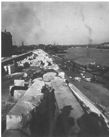
Doc 15 : construction du quai de Trinquetaille ; photo d'A. Fraix vers 1886 ; archives communales
