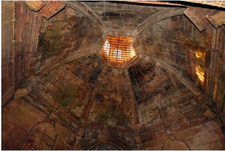
La coupole et le lanternon de la chapelle
