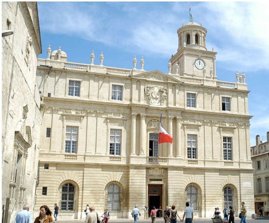
Façade sud (sur l'ancienne place du Marché), photo Ville d'Arles
