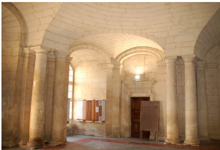
Vestibule, vue de l'angle de renforcement en abside du vestibule et de son raccord avec l'espace rectangulaire. Photo Ville d'Arles.
