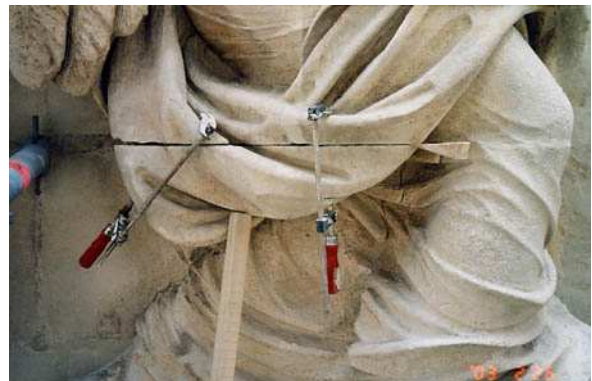
Collage avec goujons en fibre de verre d'un pan de drapé
