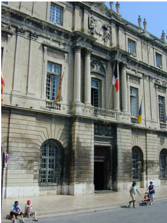
Façade avant restauration et échafaudée
