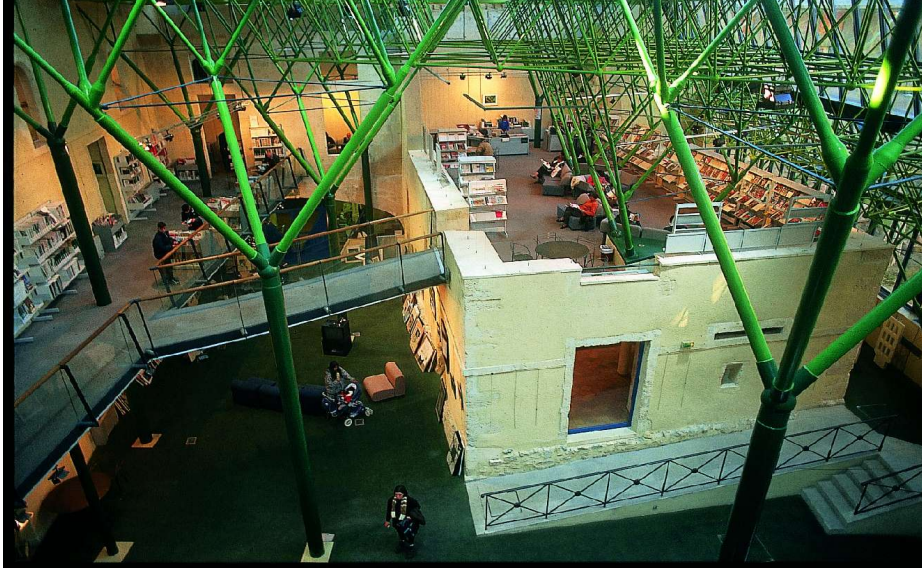
Intérieur de l'actuelle médiathèque, structures métalliques soutenant la verrière
