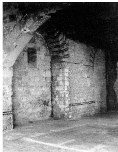
Ph. 2 : Deux fenêtres du mur sud de la basilique découvertes en 1962.
