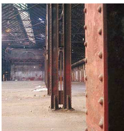
Alignement des piliers de la charpente
