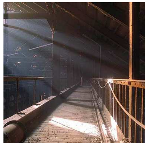
Effet de lumière sur la coursière de l'atelier de chaudronnerie
