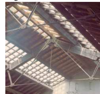
Fermes Polonceau de la chaudronnerie de fer (détail)
