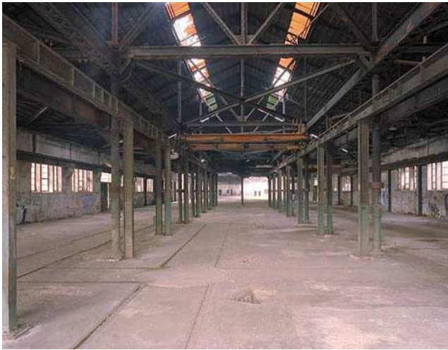
Charpente de l'atelier des roues
