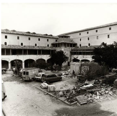
L'ancien hôpital en chantier
