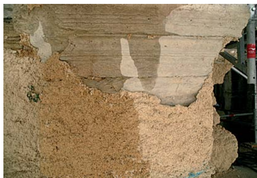
Dessalement par application de compresses par l'entreprise Tollis.
