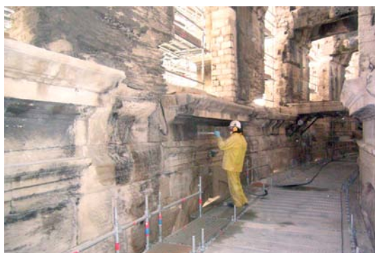
Nettoyage par hydrogommage à l'intérieur de la galerie.
