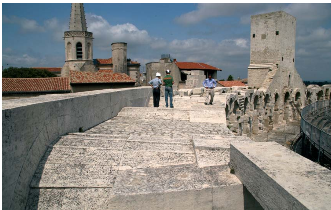
Promenade sur l'un des plus grands chantiers de restauration actuellement en cours en France.
