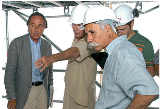
Réunion de chantier avec Alain Charles-Perrot A.C.M.H. (à gauche) et Bouzid Sabeg, directeur du patrimoine de la ville d'Arles (au premier plan).
