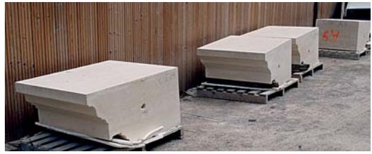
Eléments de corniche en attente sur le chantier.
