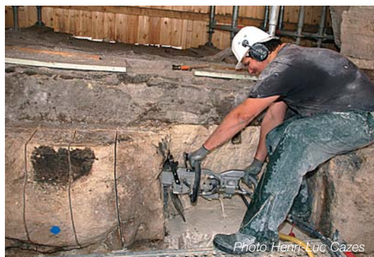
Refoulement des pierres avant leur changement.
