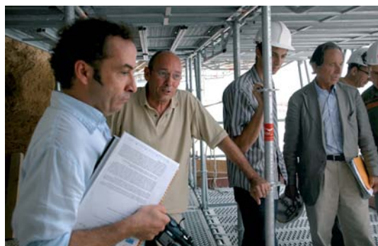
Les partenaires du chantier en réunion autour d'Alain-Charles Perrot, A.C.M.H. du chantier, dont Gilles Martinet (L.E.R.M.), et Yves Masseboeuf (Sele).
